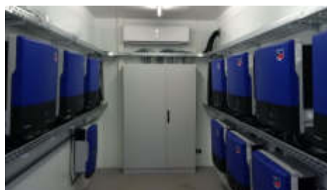
EEG-Wechselrichteranlagen
