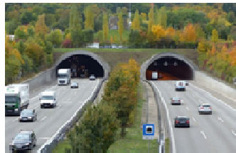
Sanierung Engelbergtunnel Leonberg
